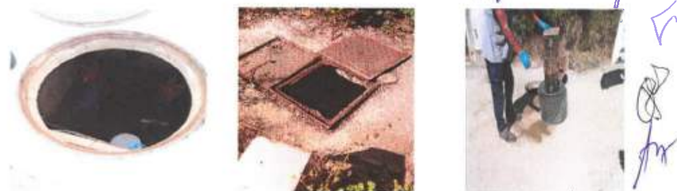
Figura 35 - Diversas instalações sob gestão da ABMG
