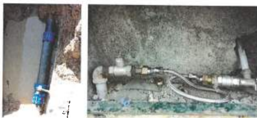
Figura 7 - Reparação de Roturas e funcionamento de ligasões depois
