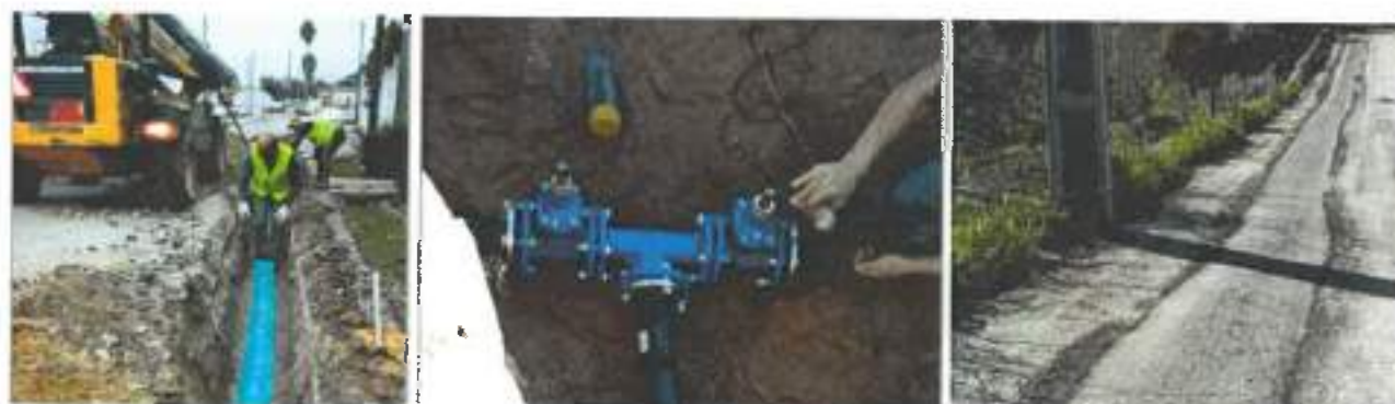
Figura 22 - Empreitada de Substituição de Condutas da rede de distribuição de água com perdas elevadas
