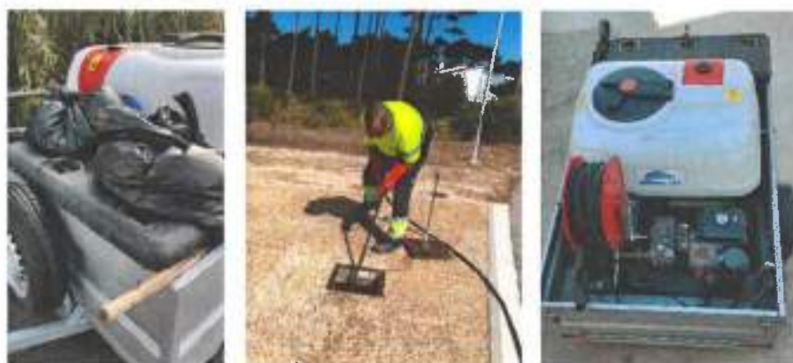
Figura 5 - Adquirição de desobstrução, trabalhos da equipa de piquete de Aljezur
