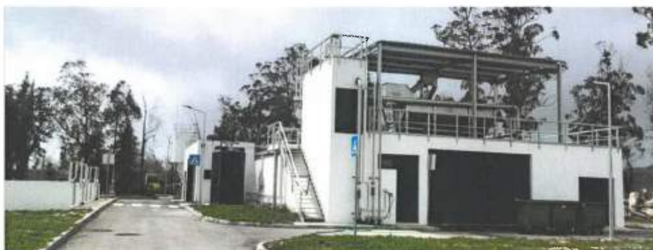
Figura 17 - Empreitada de Ampliação e Renovação da ETAR de Montemor-o-Velho
