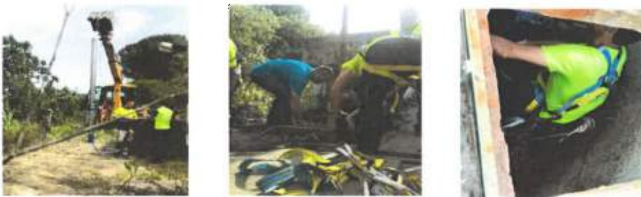
Figura 33 - Trabalhos de substituição de bomba de furo na captação do Brulho
