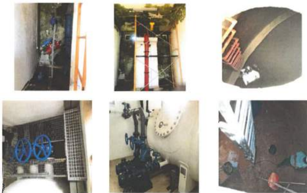
Figura 32 - Vários trabalhos no reservatório de S. Gens
