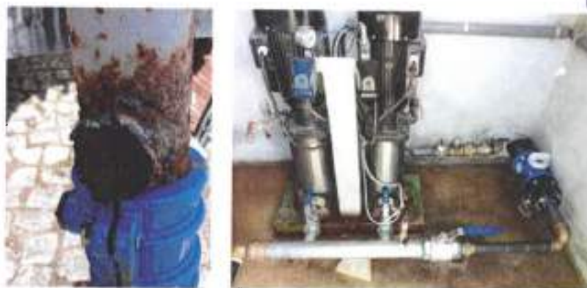
Figura 6 - Substituição da tubagem no hidroressor do Ilha Forte dos Amores, em Santo André
