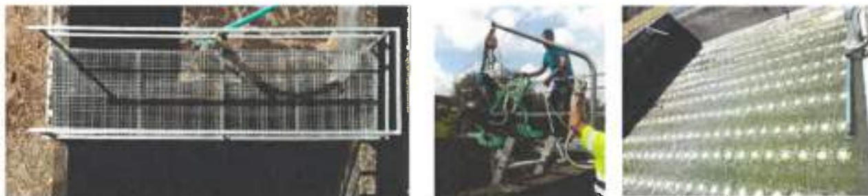
Figura 12 – Remodelação de ETAR em Soure – passadizo da ETAR do Cercal, manutenção do supressor na ETAR de Brumidos e difusores de bolha fina da ETAR de Soure
