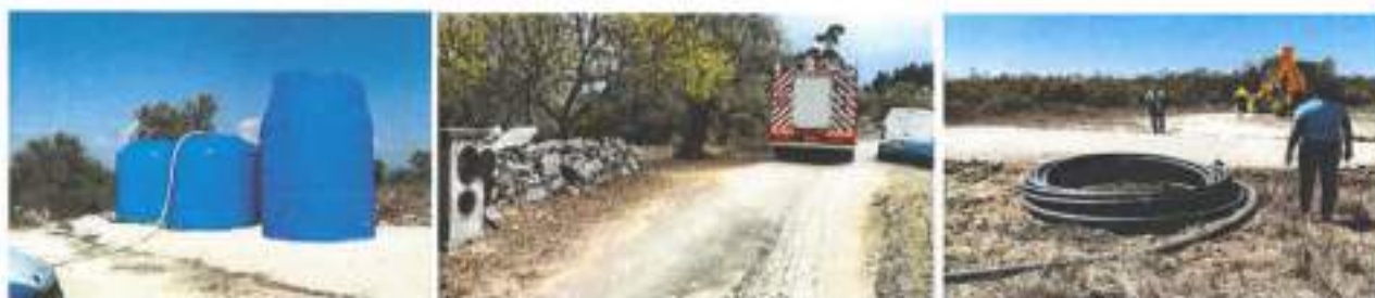
Figura 9 - Trabalhos de abastecimento alternativo à localidade de Sabugueiro
