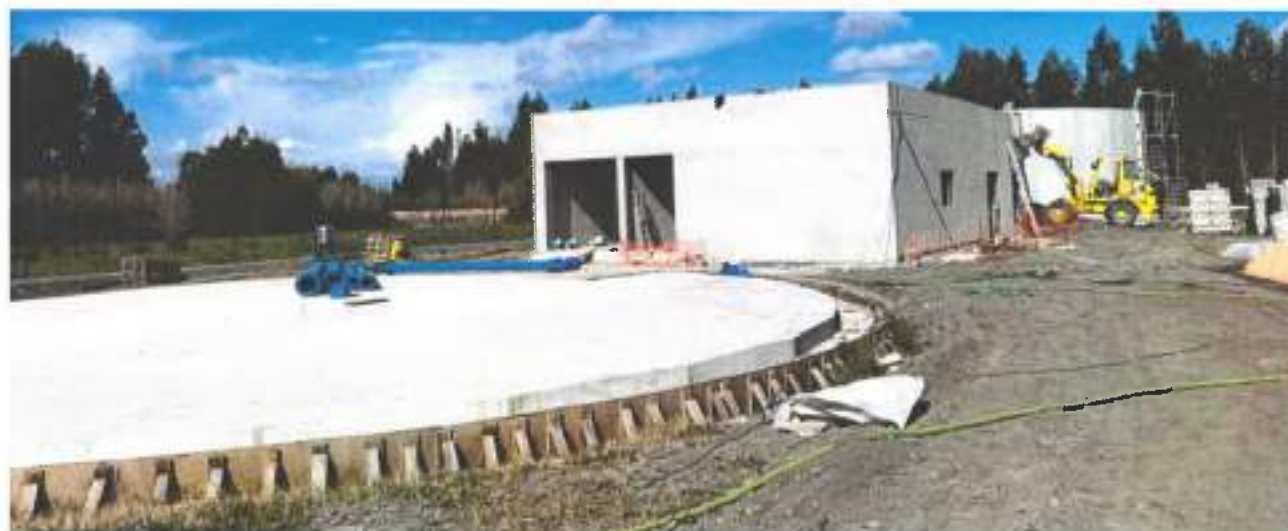
Figura 15 - Empreitada da Melhoria da Qualidade da Água em Mira
