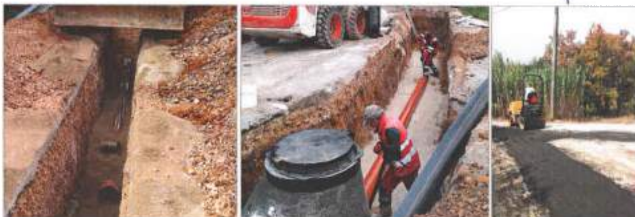
Figura 18 - Empreitada de "Construção das Redes de Saneamento, Lourenços, Moçalouro, Marco do Sul - 1ª fase (SAR de Almogreira)"
