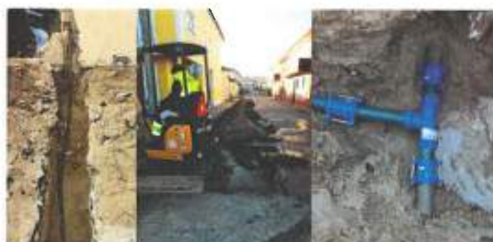
Figura 3 - Trabalhos de melhorias de rede com substituição de condutas e ramais no concelho de Mira
