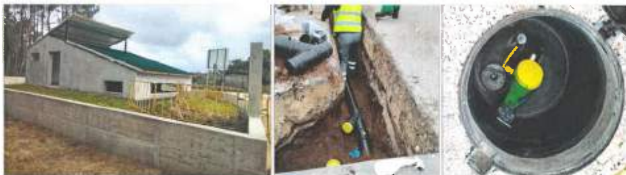
Figura 19 - Empreitada da Rede de Esgotos de Arozede (Tojeira e Cotarruchos) e Lixia (Pisão)
