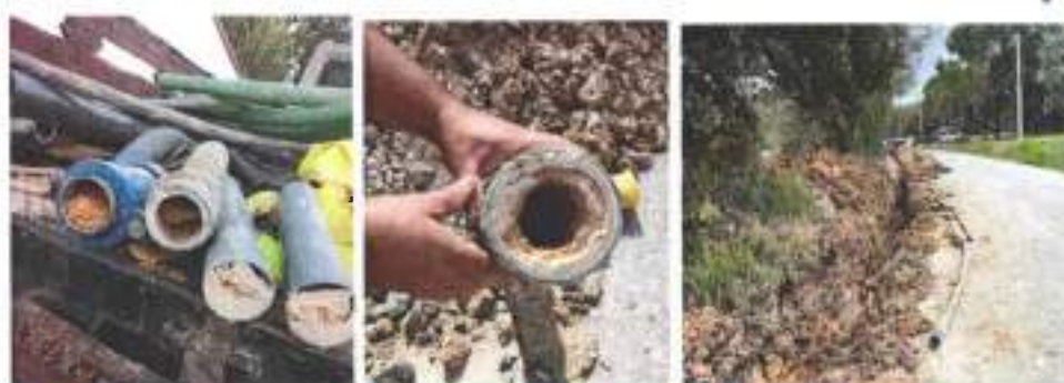
Figura 10 - Trabalhos de substituição de tubagens com excesso de colónia na localidade de Casais de São Jorge e substituição do ramal do Quinto (J. Muro)
