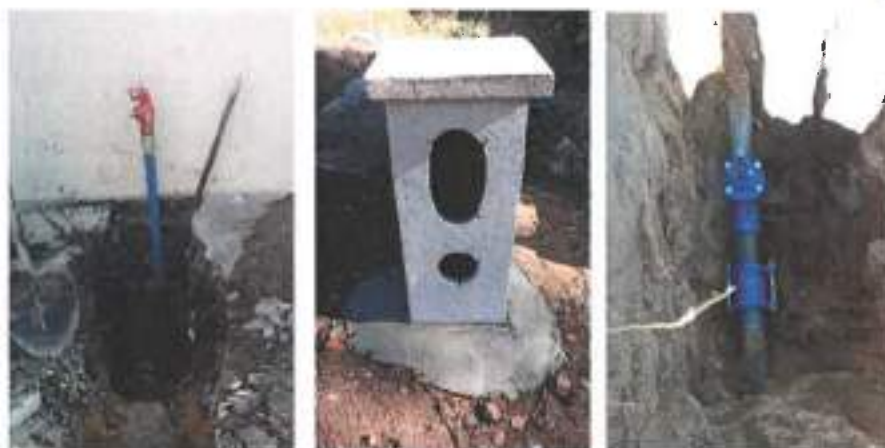
Figura 4 - Trabalhos de melhorias de rede, colocação de bocas de incêndio e válvulas de secionamento no concelho de Aljezur
