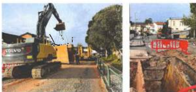
Figura 11 - Trabalhos de reabilitação do colim de Rua Helder 25 de Abril
