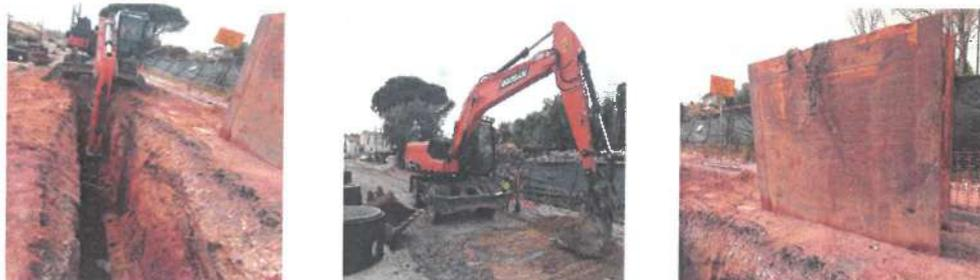
*Figura 17 - Obra de substituição de coletor de saneamento da Rua Heróis 25 de abril - Soure*
