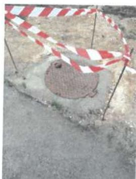
Foram garantidas também várias reposições de pavimento em tout-venant, em rasgos que aguardam pavimentação betuminosa a quente, de forma a garantir a segurança na circulação automóvel e a diminuição das reclamações por falta de pavimento.
