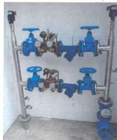
*Figura 9 - Posto de Controlo e Redução de Pressão de Meãs do Campo*
