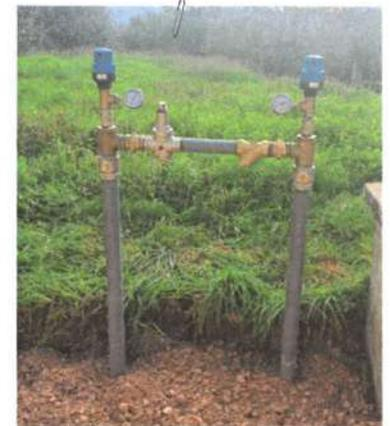
Figura 11 - VRP instaladas pelas equipas ABMG no Concelho de Soure
