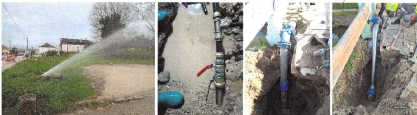
Figura 10 - Reparação de roturas na Rede de Abastecimento em Montemor-o-Velho
