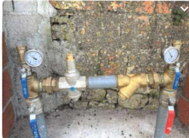
Figura 13 - Válvula redutora de pressão
