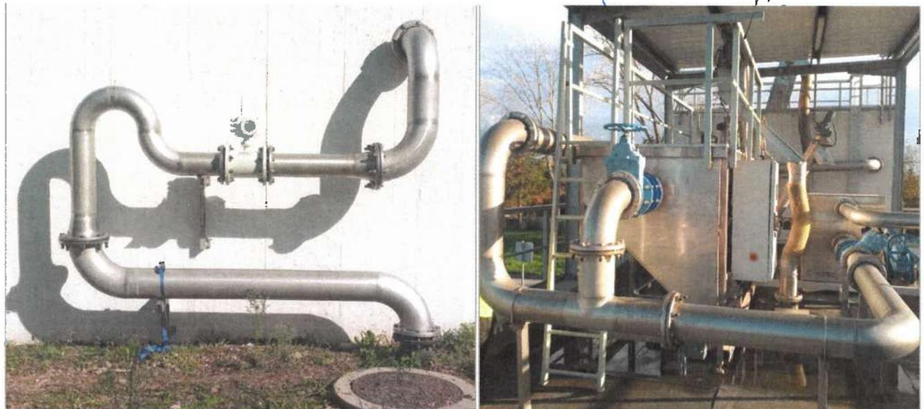
Figura 18 - Instalação de caudalímetro e guarda da Unidade Combinada da Obra de Entrada
