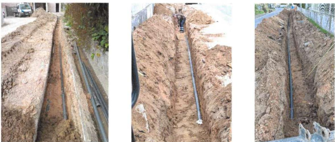
Figura 9 - Prolongamento de Rede de Abastecimento e Substituição de Conduitas, realizadas pelas equipas ABMG em Montemor-o-Velho
