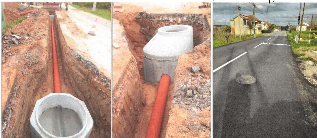
Figura 20 -- Instalação de coletor e ramal de SAR
