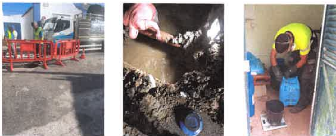
Figura 14 - Acompanhamento de trabalhos de manutenção e reparação de equipamentos e infraestruturas
