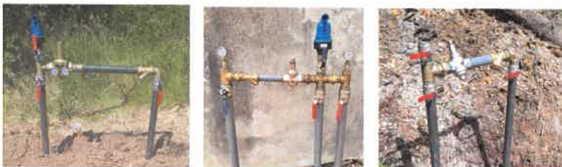
Figura 7 - Instalação de VRP
