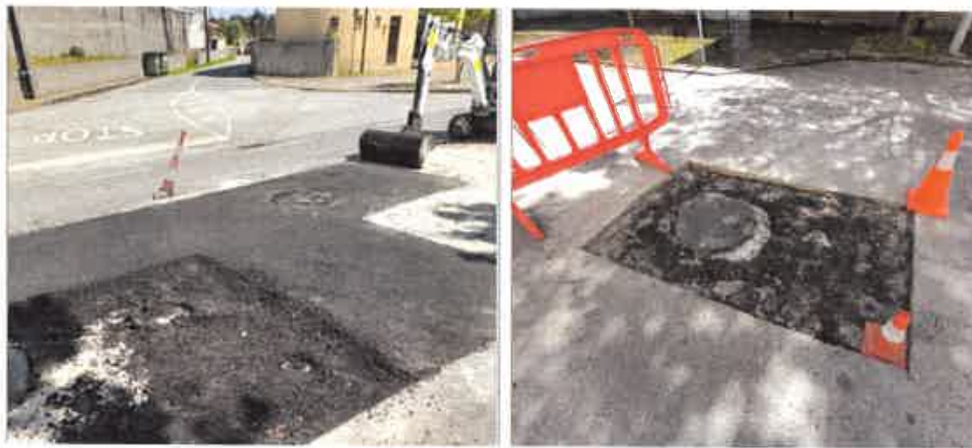
Figura 8 - Caixas de visita intervencionadas na EN 109 - Mira
