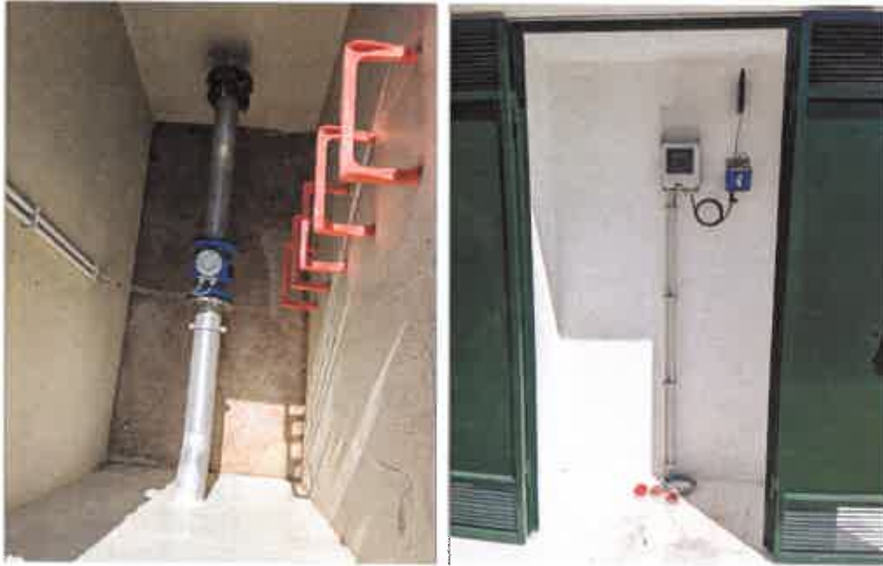
Figura 11 - Caudalímetro e cabine técnica
