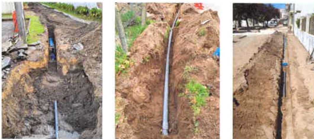
Figura 4 - Execução de prolongamentos de rede de abastecimento de água
