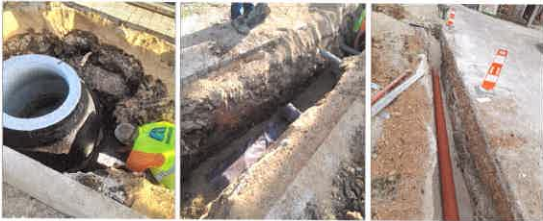
Figura 9 - Instalação de caixa de visita e coletores
