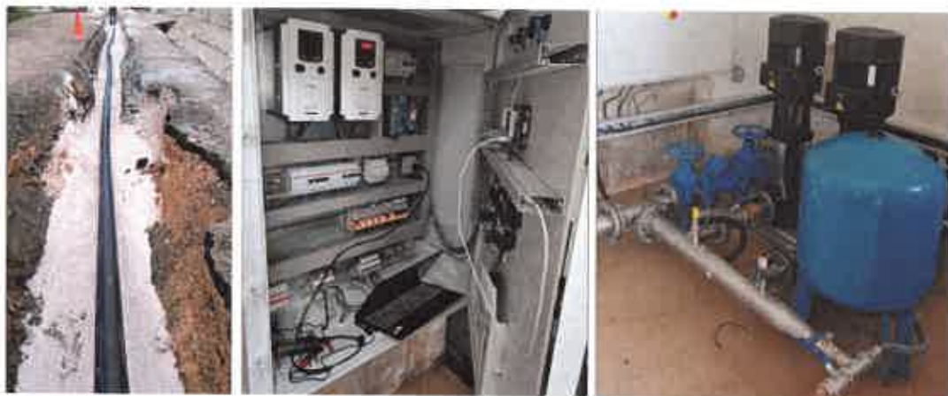
Figura 10 - Instalação de conduta de Abastecimento de Água, Quadro Elétrico e Hidroressor
